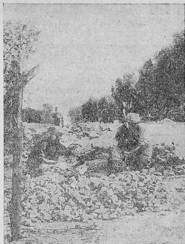
Разбивка камня для ремонта дорог на тракте Серпухов—Тула
